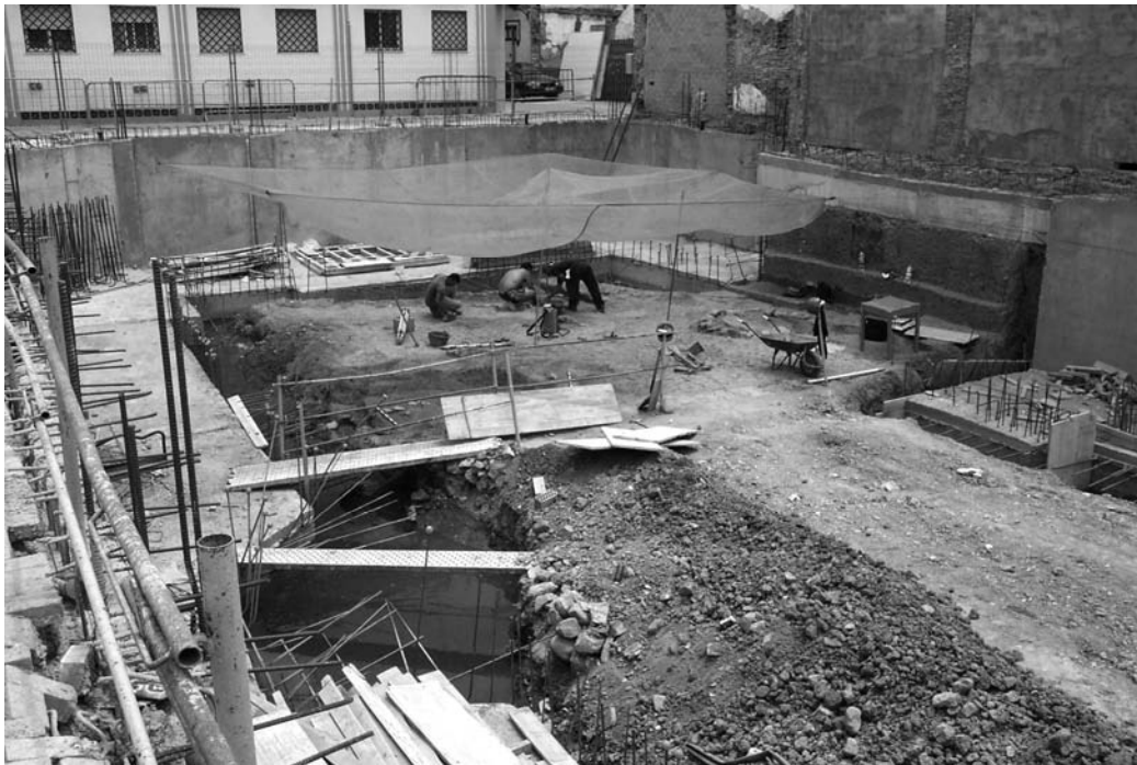
Lám. I. Solar durante los trabajos de excavación.
